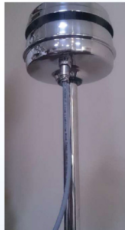
32 Test Kablosunun paratoner soketine bağlantısı yapıldı The Test cable & Lightning Rod test socket connection completed
