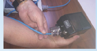
4 Yıldırım Sayıcının Test Kablo bağlantısı yapıldı Lightning Strike Counter Test cable connection was completed
