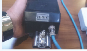
6 Yıldırım Sayıcının göstergesindeki sayıya bakıp kaç olduğunu kontrol ediniz 28 olduğu görülüyor Check the Lightning Strike Counter indicator (28)
